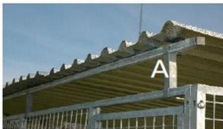
**Partie avant avec support et tube support**
