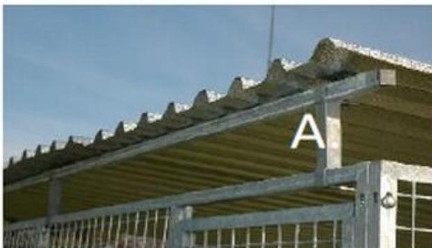
**Partie avant avec support et tube support**
