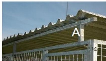
**Partie avant avec support et tube support**
